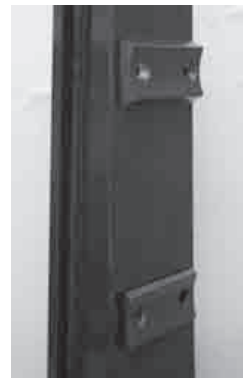
図-12 支柱と横梁の締結のための台座
