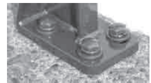
図-15 支柱とアンカーの締結方法と、ベースプレート角部の面取り
