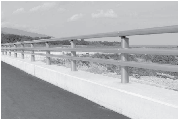
図-23 本防護柵の設置事例（3本ビームタイプ）
