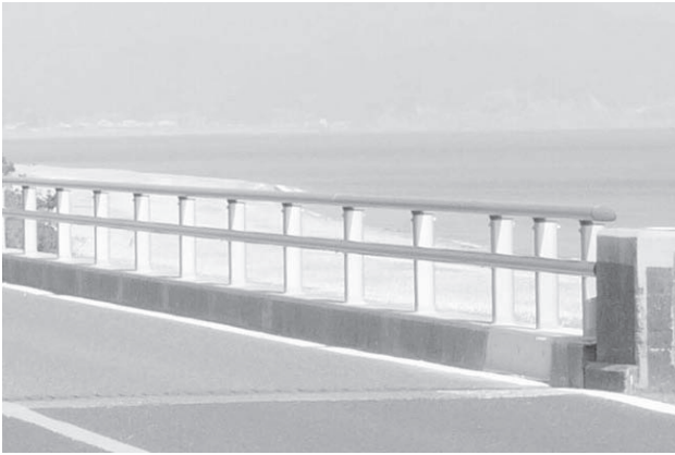
図-22 本防護柵の設置事例（2本ビームタイプ）
