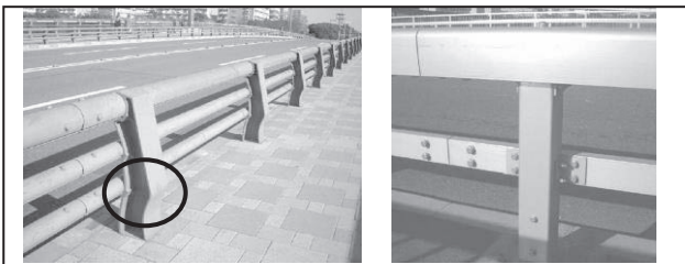
図-1 既存丸ビーム防護柵(左)と既存角ビーム防護柵(右)
