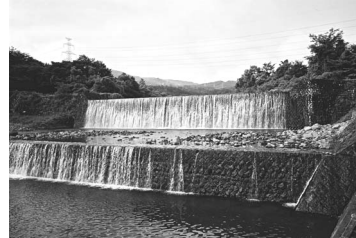
図-2 地蔵原堰堤
