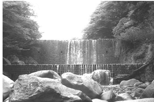
図-7 荒川第6堰堤下流面
