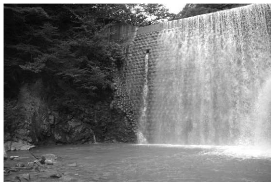
図-8 荒川第3堰堤下流面
