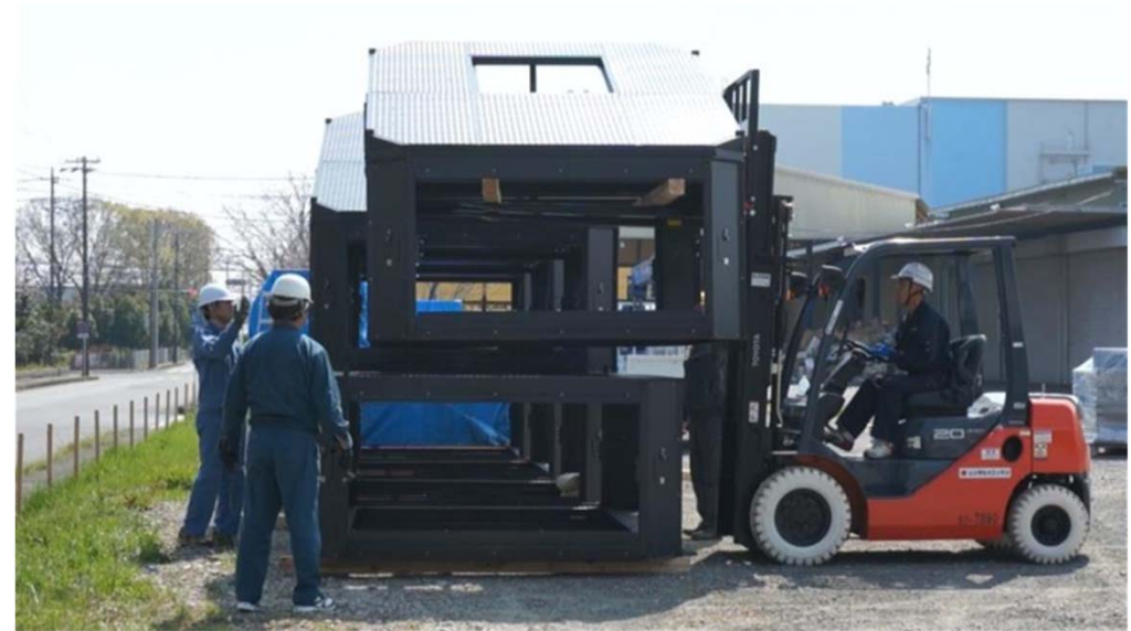
フォークリフトによる災害救助訓練ユニットの組立て
