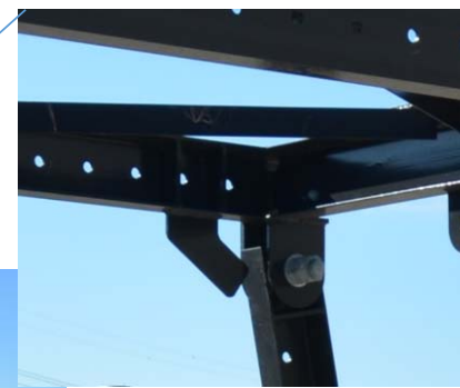
倒れ角度を制限するストッパーによる安全確保
