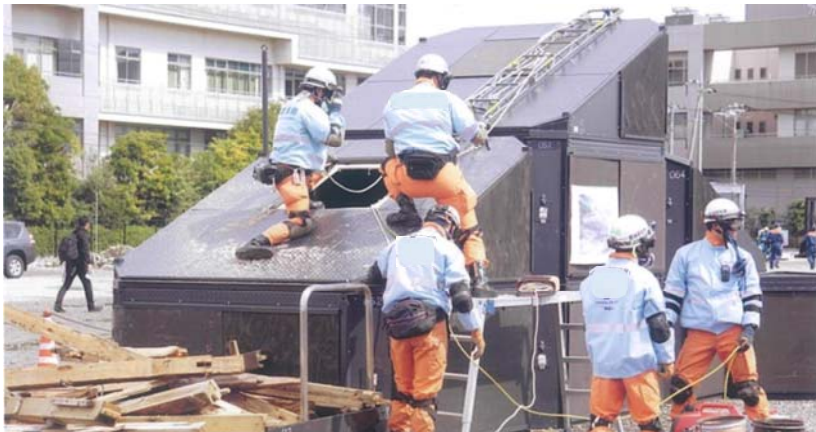
瓦礫により倒壊し、埋もれた家屋からの屋根を切断しての救出訓練。ユニット構成は、p3に掲載
