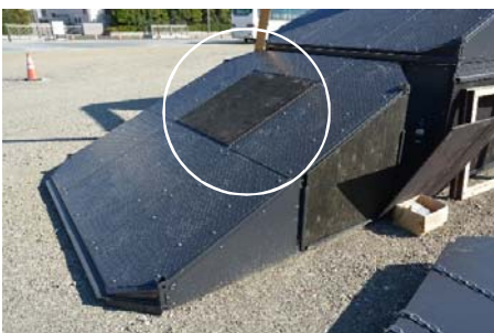
屋根面に設けた救助訓練用の穴
