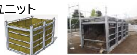
土砂埋没被災者救助訓練 ユニット用足場
