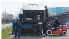
写真8 フォークリフトでユニットの移動を行う
